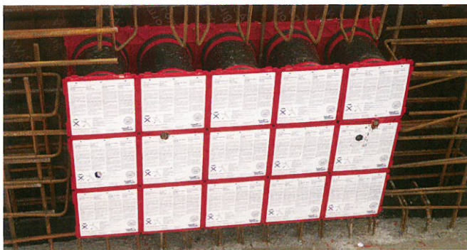
ダブルウォールインサート HSI 150 を配筋に取り付けた事例
