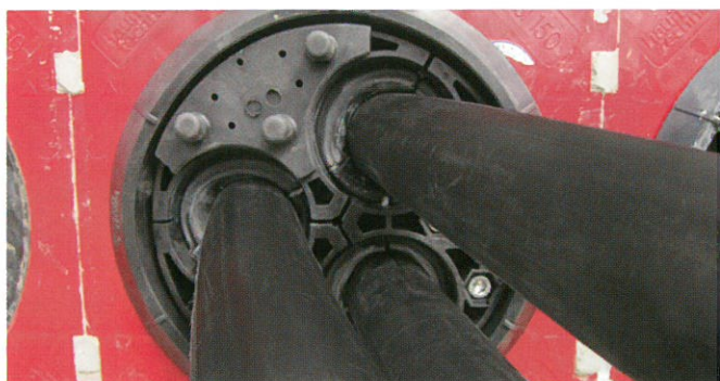
プレッシュャープレートカバー取付例 (HSI 150-PA-3/24-54)
