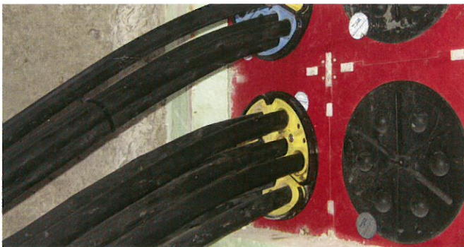
街灯用ケーブルのシーリング施工例 (HSI 150 セグメント方式)
