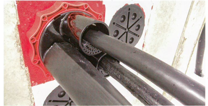
システムカバー (HSI150-D3/58) 内で、センタリングテープを使用し、ケーブルをソケットの中央に配置する。
