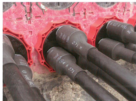
コールドシュリンク方式施工例 (HSI150-D3/58)
