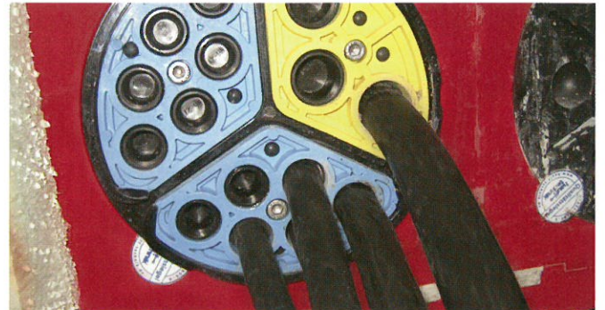
ボルトは全てトルク管理にて締め付けます。使用しない穴は、ブラインドプラグにて閉止します。(HSI 150 セグメント方式)
