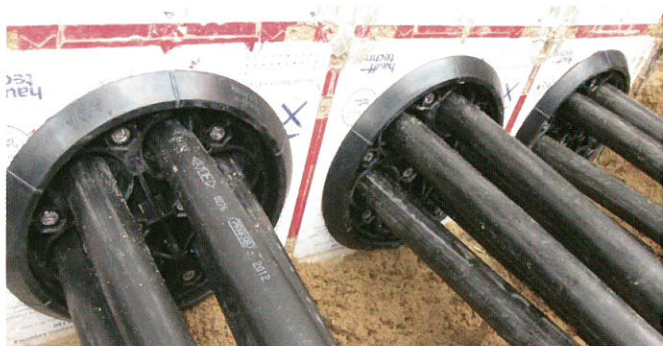
低圧ケーブルへの施工例 (HSI 150-DG-6/10-36)
